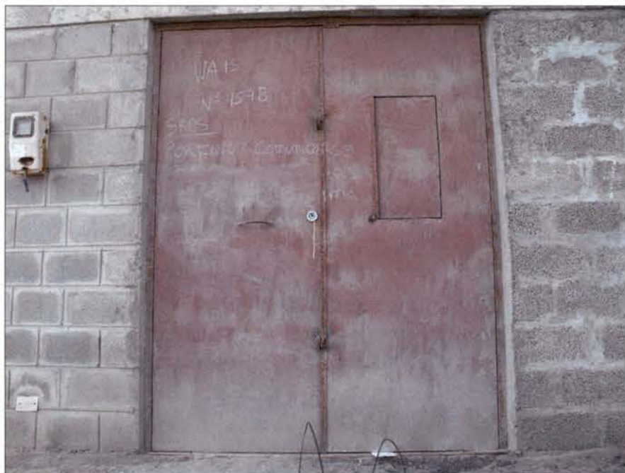
Ilustra una vista de la puerta de acceso al inmueble ubicado en Pasaje Punta Arenas 4578
